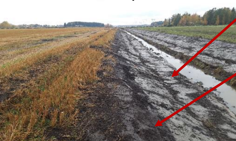
Kaksitasouoma heti kaivamisen jälkeen lokakuussa 2020
